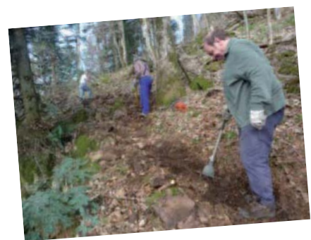
Pose de bancs et table à la Roche Marchal
